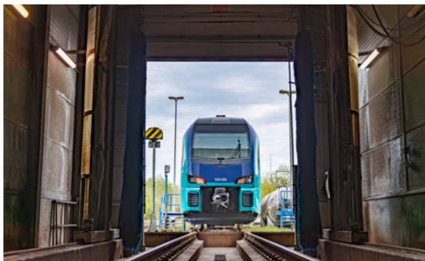
Das Depot ist auf die Besonderheiten der FLIRT Akku und ihrer Batterien ausgerichtet.
